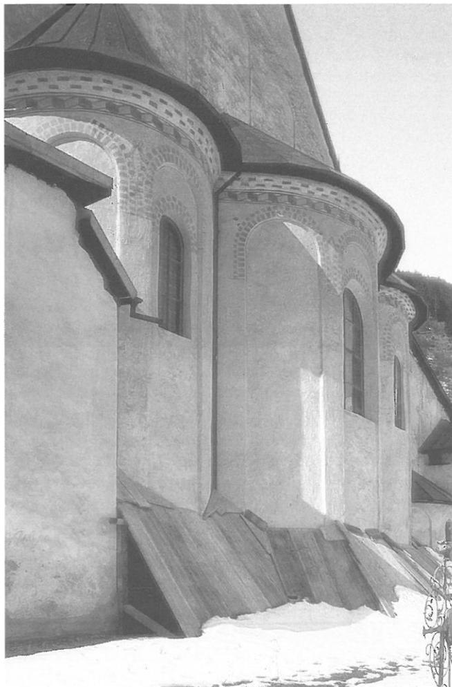
**Müstair/GR, Kloster. Der einfache Schneeschutz verhindert die Durchfeuchtung der Wand und reduziert Schäden an den kostbaren Wandmalereien im Inneren.**
