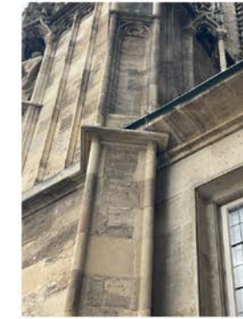
Übergang Dom - Anbau
