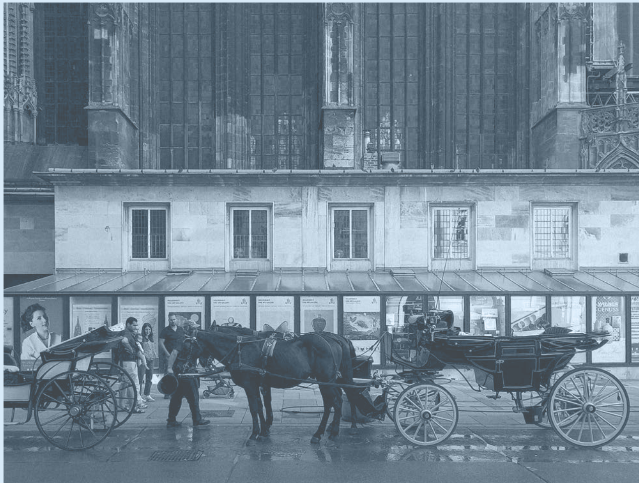
Hauptfassade der Dombauhütte im aktuellen Zustand mit Vitrinenwand und Zubau
