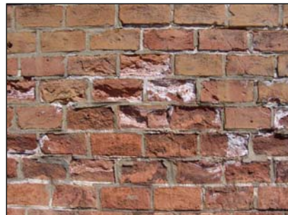
Wien 3, Arsenal, Salzausblühungen aus Ziegelmauerwerk Sommer 2006
