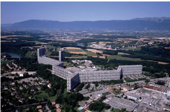
Herausforderung Nachkriegsmoderne: Großsiedlung Le Lignon in Genf nach der Fertigstellung; 2700 Wohnungen für 10'000 Personen - unter Denkmalschutz und seit 2012 im Zuge einer denkmalgerechten Sanierung
