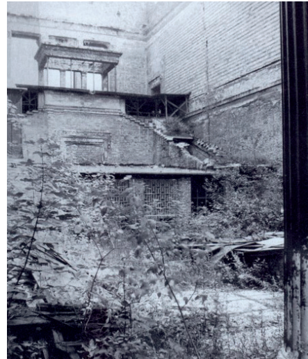
Neues Museum in Berlin, 1843-1855 von Friedrich August Stüler , Treppenhaus nach dem Brand vom 22./23. November 1943; im Februar 1945 schwerwiegende Zerstörungen durch Bomben.
