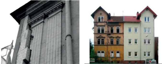
Herausforderung Energie: Inakzeptable Außendämmung an einem historischen Gebäude (Objekt unbekannt); Doppelhaus, links in ursprünglichem Zustand mit Fassadengliederung und Dekor, rechts mit Außendämmung ...
