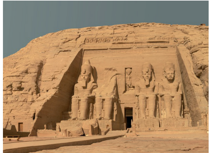
Translozierung: Abu Simbel. Der große Tempel von Ramses II. am neuen Standort. Die Einzelteile wurden wieder zusammengefügt und -geklebt.
