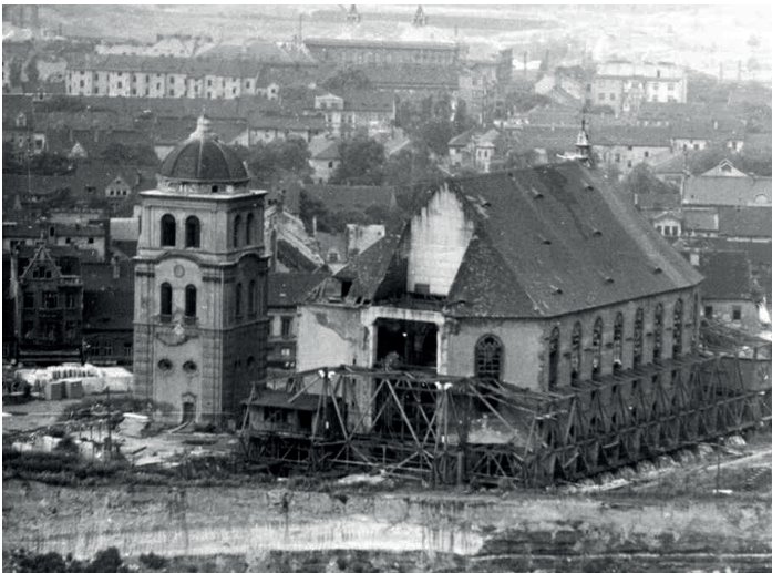
1970 wurde wegen des Kohletagbaus die gesamte historische Stadt abgetragen. Die Kirche wurde geschont und transloziert. Mit abgebrochenem Frontturm wird die Kirche für die Translozierung bereitgestellt.
