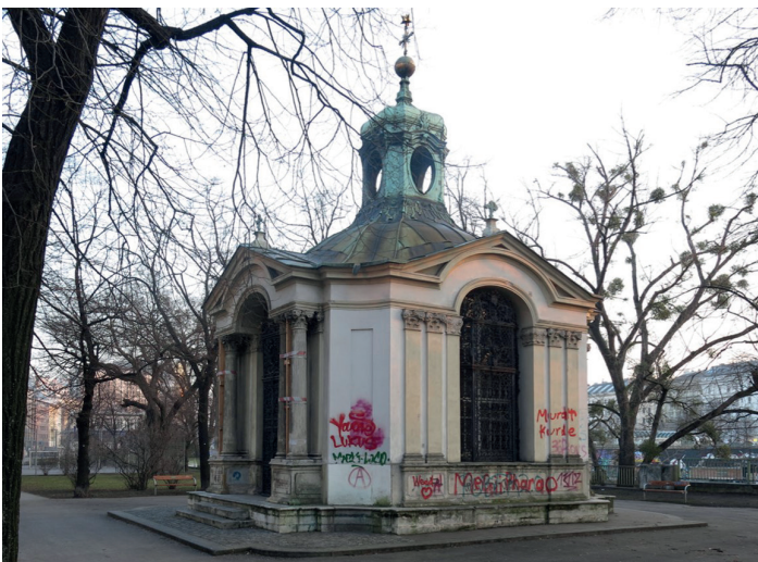
St. Nepomukkapelle von 1774 (vermutlich nach Plänen von Anton Ospel), 1908 an den heutigen Standort an die Obere Donaustraße, linkes Ufer des Donaukanals zum zweiten Mal transloziert bzw. unter Verwendung originaler Bauteile wieder aufgebaut und in der Ausstattung ergänzt.
