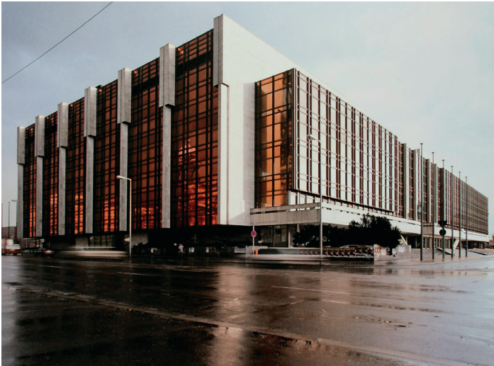
„Streitwert“: Berlin, Palast der Republik, 1973 und 1976 nach Plänen von Heinz Graffunder (1926-1994) erbaut, von Februar 2006 bis Dezember 2008 schrittweise abgerissen
