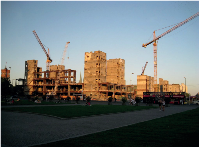
Berlin, Abriss des Palastes der Republik, von Feb. 2006 bis Dez. 2008
