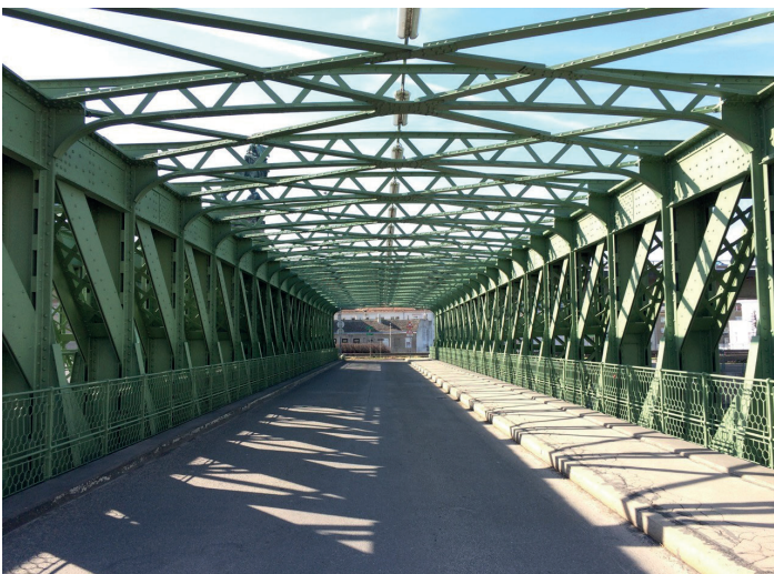
Gebrauchswert; Eiserne Fachwerkbrücke bei der Nussdorfer Schleusenanlage am Donaukanal in Wien sog. Schemerlbrücke, benannt nach dem k.k. Hofbau- ratsdirektor Josef Schemerl Ritter von Leytenbach, 1894-1899 von Otto Wagner geplant.
