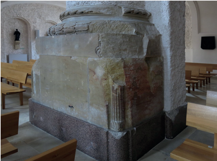
Dresden, Kreuzkirche nicht restaurierte und rekonstruierte Stützenbasis mit Kriegsschäden.
