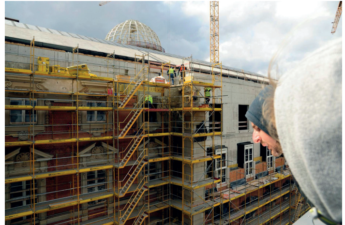
Neues Berliner Schloss im Bau, 2017
