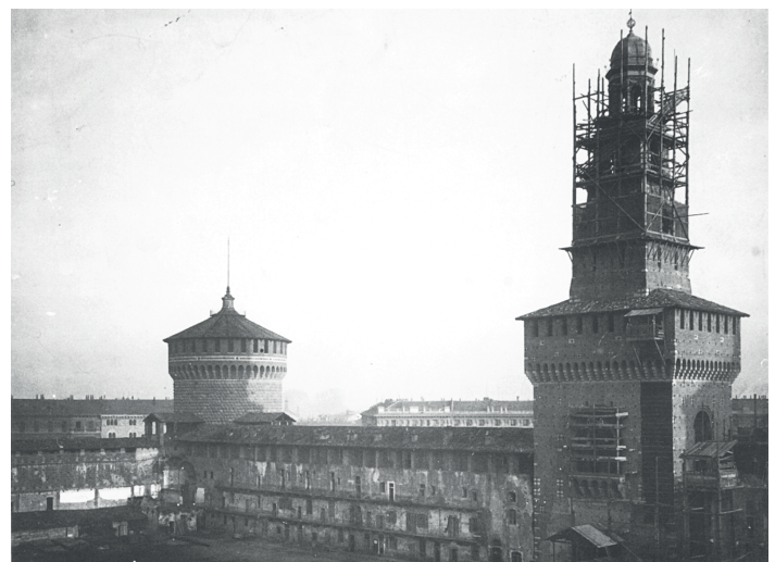
Mailand, Castello Sforzesco, Torre del Filarete Rekonstruktion kurz vor der Vollendung 1901
