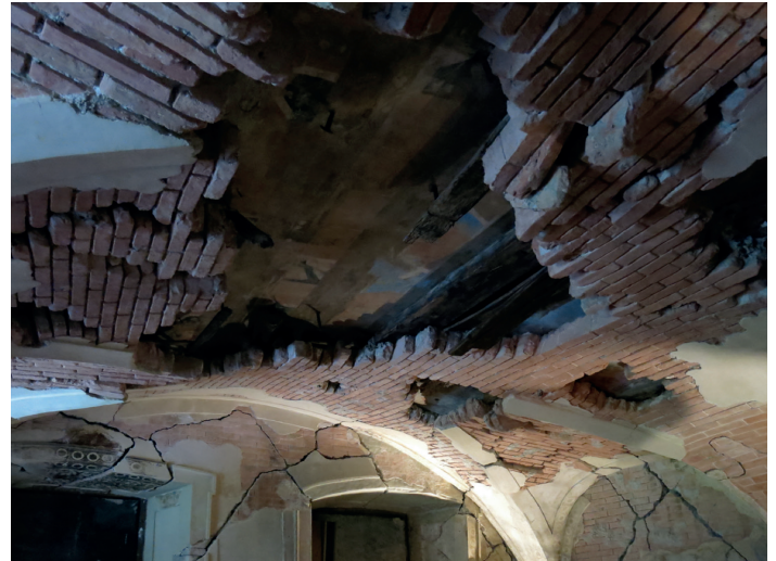
Schloss Hellbrunn Deckengewölbe der „Ruinengrotte“
