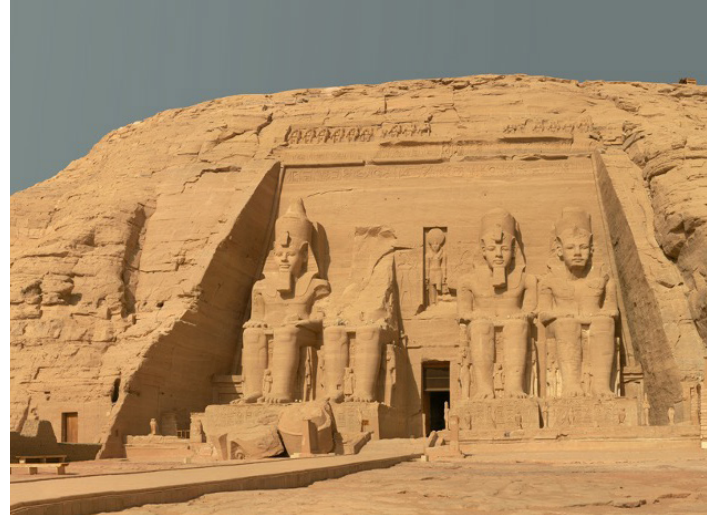
Translozierung: Abu Simbel. Der große Tempel von Ramses II. am neuen Standort. Die Einzelteile wurden wieder zusammengefügt und -geklebt.
