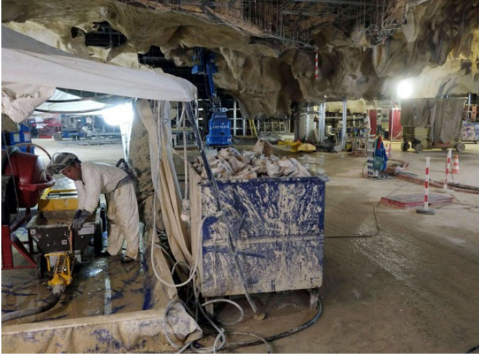
Bauarbeiten im Inneren der Kopie der Höhle „Chauvet“ in Vallon-Pont-d'Arc (Ardèche F).
