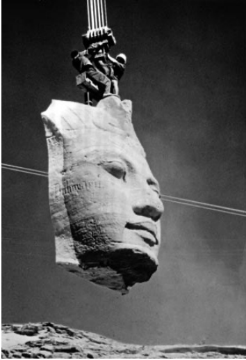
Translozierung: Abu Simbel. Mit Kran abgehobener Teil eines Statuenkopfs; Grundriss des „neuen“ Tempels unter einer riesigen Stahlbetonkuppel.
