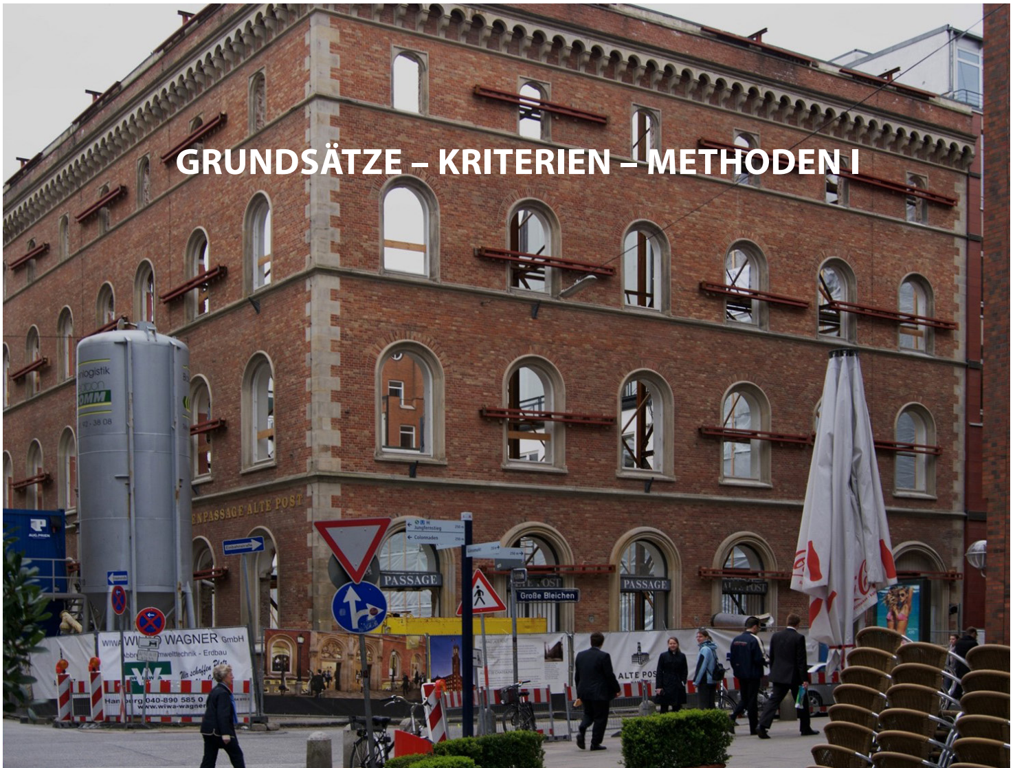
Alte Post in Hamburg, 1842-47 nach dem großen Brand von 1842 nach Plänen von Alexis de Chateauneuf errichtet; denkmalgeschützt; nach Umbau von 1971 Ladenpassage; jüngst erneuter Umbau (Auskernung) zu einem Bürohaus.
