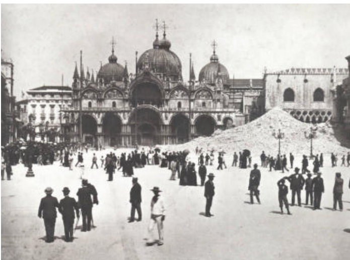
Venedig, Piazza San Marco mit Campanile, am 14. Juli 1902 eingestürzt
