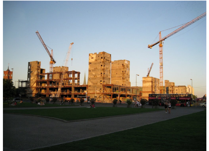
Berlin, Abriss des Palastes der Republik, von Feb. 2006 bis Dez. 2008
