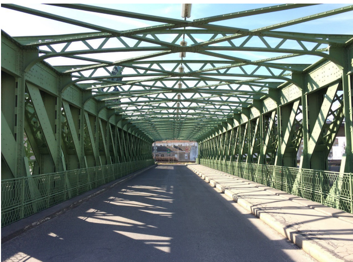
Gebrauchswert; Eiserne Fachwerkbrücke bei der Nussdorfer Schleusenanlage am Donaukanal in Wien sog. Schemelbrücke, benannt nach dem k.k. Hofbau- ratsdirektor Josef Schemel Ritter von Leytenbach, 1894-1899 von Otto Wagner geplant.
