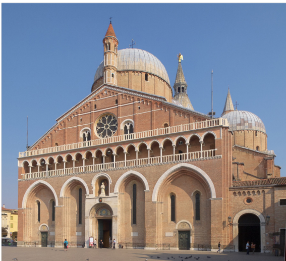
Padua (I), Basilika Sant' Antonio (il Santo), 1232 bis Mitte 14. Jh. 1895-99 durch Camillo Boito restauriert
