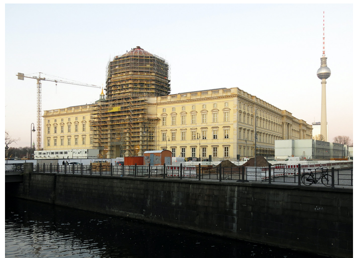
Neues Berliner Stadtschloss mit Humboldtforum im Bau, Dez. 2019
