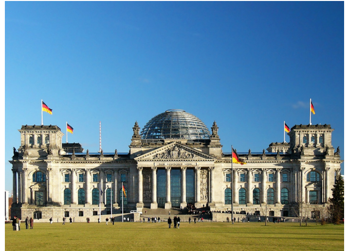
Berliner Reichstagsgebäude heute umfassende Erneuerungs- und Restaurierungsarbeiten samt neuer Kuppel durch Norman Foster, 1995-1999
