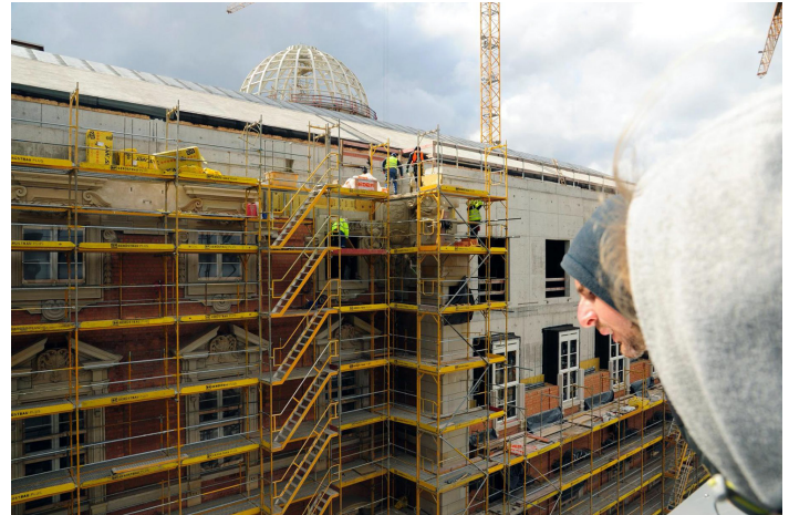
Neues Berliner Schloss im Bau, 2017
