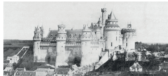
Schloss Pierrefonds vor und nach der Restaurierung (Foto Lebrun 1857)
