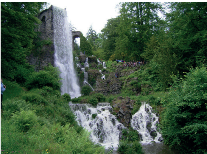
Wilhelmshöhe bei Kassel, Aquädukt von Heinrich Christoph Jussow 1788 bis 1792
