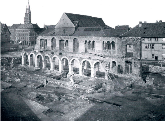
Braunschweig, Burg Dankwarderode, ab 1175 durch Heinrich dem Löwen erbaut, nach Brand 1873 entdeckte Ruinen der alten Burg
