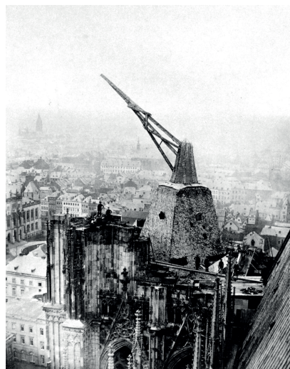
Domkran vor Beginn des Abbruchs, Foto um 1868 (Köln, Dombauarchiv)
