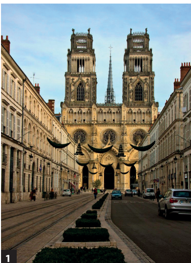
Die lange Baugeschichte der gotischen Kathedrale von Orléans (F) (1), 13./14. Jh., 1601 ff., ist über Jahrhunderte vom Prinzip der Konformität geprägt. Erst 1829 wird der Vierungsturm (2) in Holz und Blei gebaut.
