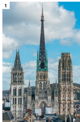
Die gotische Kathedrale von Rouen (F) (1), 12./13. Jh., erhielt erst 1884 einen neuen, sehr hohen Vierungsturmaufsatz (2) aus Eisen und Gusseisen. Formal dem Konformitätsprinzip folgend, materiell und konstruktiv aber zeitgenössisch nach neuestem Stand der Technik
