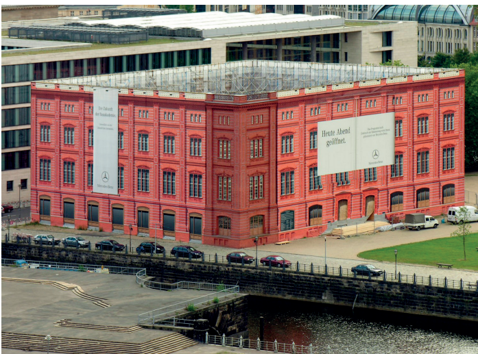
Bauakademie in Berlin , Attrappe mit bemalter Plane (2004) vordere Ecke gemauerte Rekonstruktion (2001)
