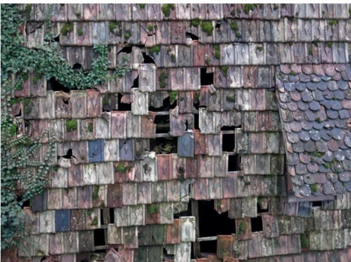
Instandhaltung: z.B. Dachziegel nachstecken, morsche Dachlatten ersetzen
