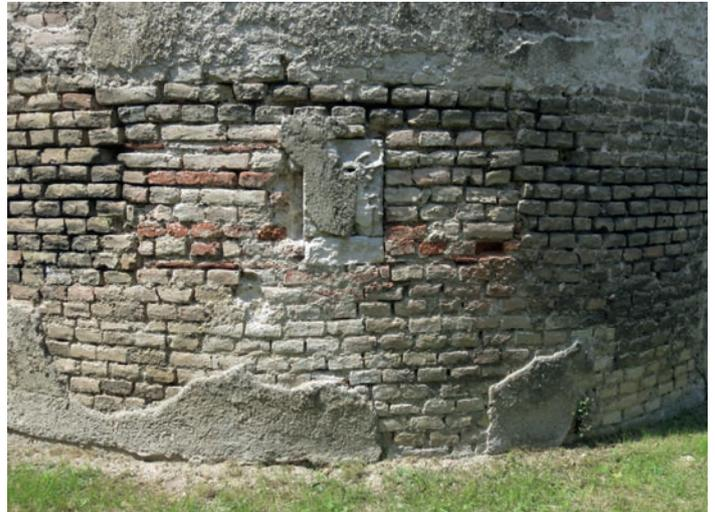
**Instandsetzung, Reparatur:** Um das Mauerwerk zu schützen, sollten fehlende Putzstellen wieder in Stand gesetzt werden.
