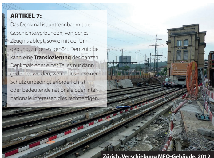
Zürich, Verschiebung MFO-Gebäude, 2012
