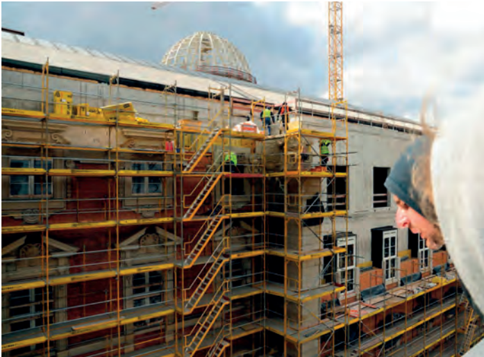
Neues Berliner Schloss im Bau, 2017
