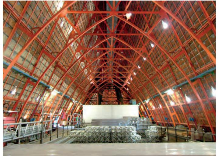
Bei der Vollendung des Kölner Doms hat man sich der neuesten Technik bedient und im Dach keine Holzkonstruktion, sondern ein modernes Eisentragwerk eingebaut.
