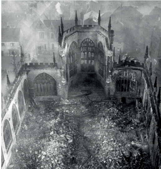
Zerstörte gotische Kathedrale von Coventry GB, am 14. Nov. 1940 bombardiert.
