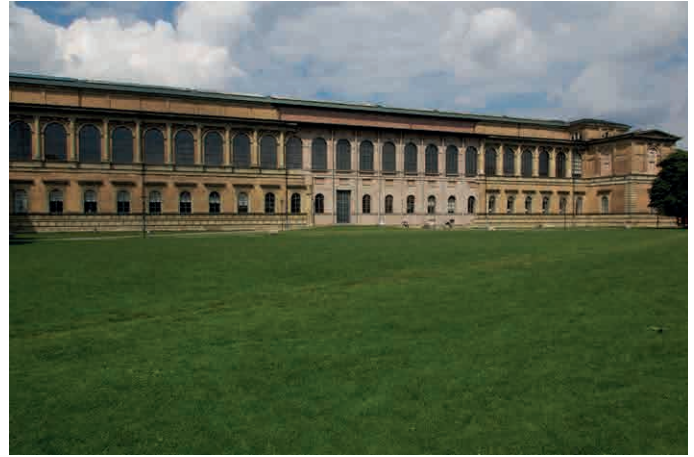
Alte Pinakothek in München, nach den Kriegszerstörungen 1952-1957 durch Hans Döllgast (1891-1974) in hervorragender Art restauriert und ergänzend wiederaufgebaut.
