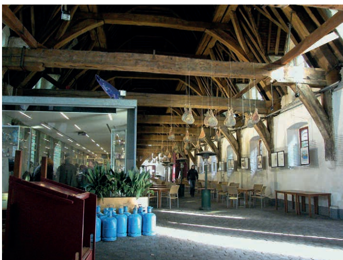
Sanierung: Die Nutzung muss mit dem Denkmal verträglich sein. Erneuern darf nicht zerstören; moderner Stahl/Glas-Einbau in der alten Fleischerhalle in Gent, 15. Jh.
