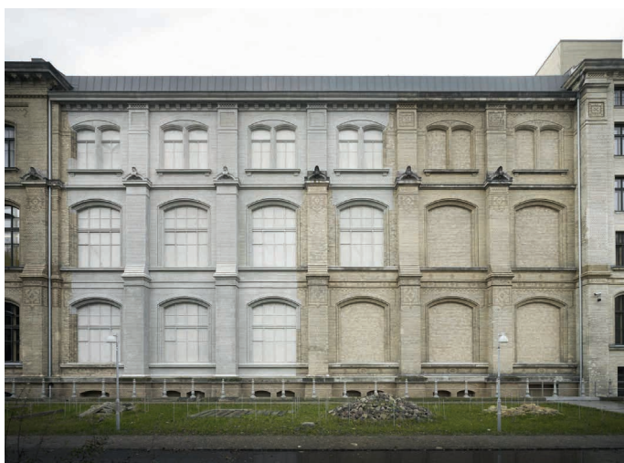
Ergänzung: Museum für Naturkunde Berlin; Ergänzung des teilweise zerstörten Ostflügels durch einen inneren neuen Kern und Weissbetonabgüsse an der Fassade (2005-2010, Arch. Diener & Diener).
