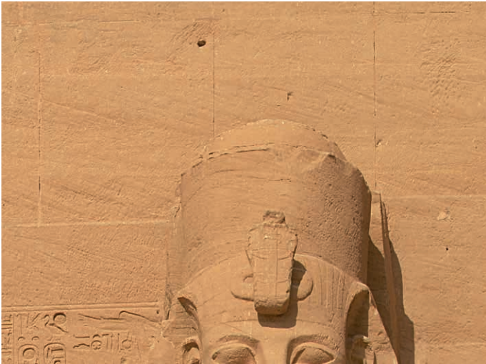
Translozierung: Abu Simbel. Nahansicht eines Teils des grossen Tempels mit klar erkennbaren Sägeschnitten.
