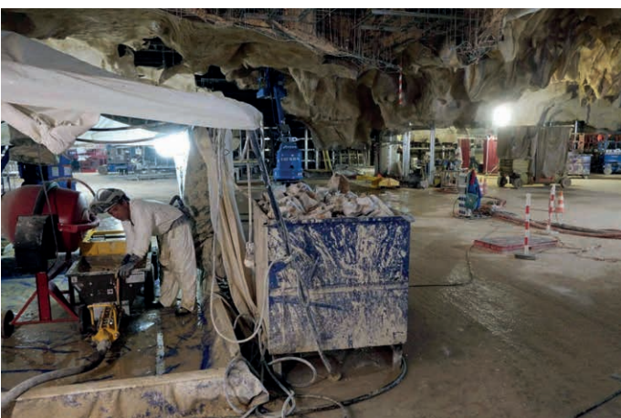
Bauarbeiten im Inneren der Kopie der Höhle „Chauvet“ in Vallon-Pont-d'Arc (Ardèche F).
