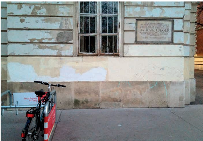
TU Hauptgebäude: Schäden behoben, Bild 2014.
