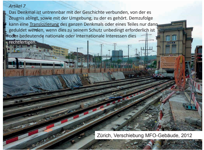
Artikel 7: Translozierung als ultima ratio. Illustration: Spektakuläre Verschiebung des ehem. Verwaltungsgebäudes der MFO in Zürich Oerlikon (1889) am 22.5.2012 (in 19 Std. 6500 t um 63 m verschoben (MFO= Maschinenfabrik Oerlikon, heute ABB))
