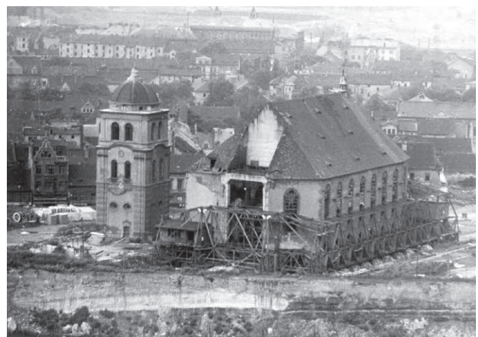
1970 wurde wegen des Kohletagbaus die gesamte historische Stadt abgetragen. Die Kirche wurde geschont und transloziert. Mit abgebrochenem Frontturm wird die Kirche für die Translozierung bereitgestellt.
