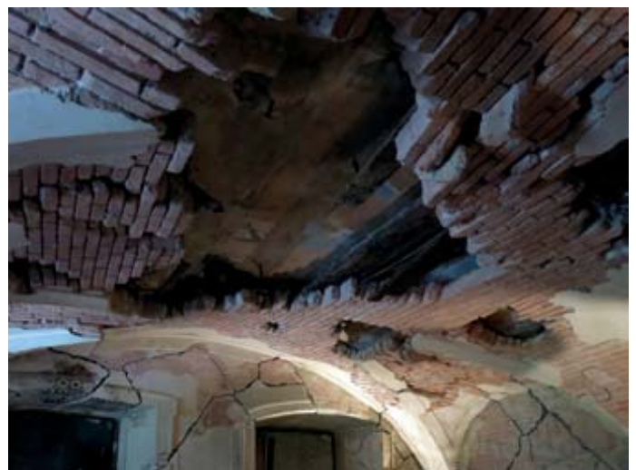
Schloss Hellbrunn Deckengewölbe der „Ruinengrotte“
