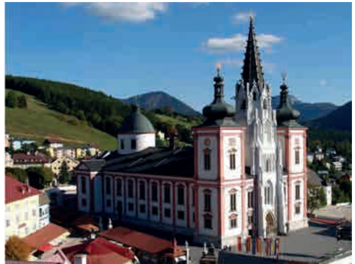
Wallfahrtskirche Mariazell, (Steiermark) Aussenansicht: Einbezug des gotischen Frontturms aus dem 14. Jh. in die barocke Erweiterung durch Domenico Sciascia.
