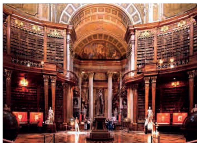
Hofbibliothek Wien, heute Nationalbibliothek, Prunksaal mit Kuppelfresko von Daniel Gran, 1726-1730. Nach Setzungen im Gebäude und Rissen in der Kuppel (1750er Jahre) 1763 von Hofarchitekt Nikolaus (Niccoló Pacassi 1716-1790) mit einem Eisenring verstärkt.
