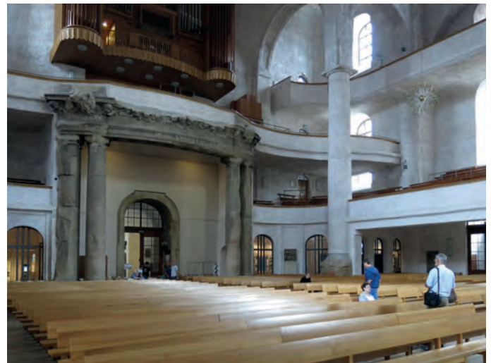
Dresden, Kreuzkirche Inneres gegen Westen, mit lediglich stabilisierter, aber nicht restaurierter und rekonstruierter Portalrahmung nach Kriegsschäden. Als Mahnmahl belassen.
