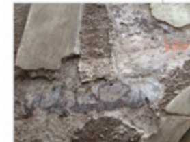
Rekonstruktion Sgraffito Fries und Einfärbung der unterschiedlichen Putzschichten
