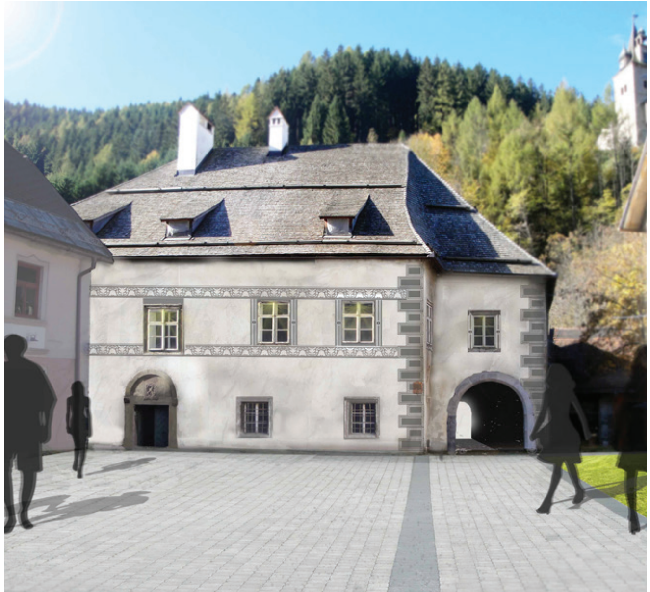
Hauptfassade mit freigelegtem Fries
