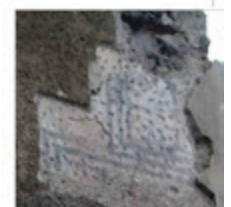
Rekonstruktion Sgraffito Fries und Einfärbung der unterschiedlichen Putzschichten
