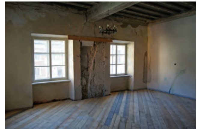
Innenraum im Obergeschoss
