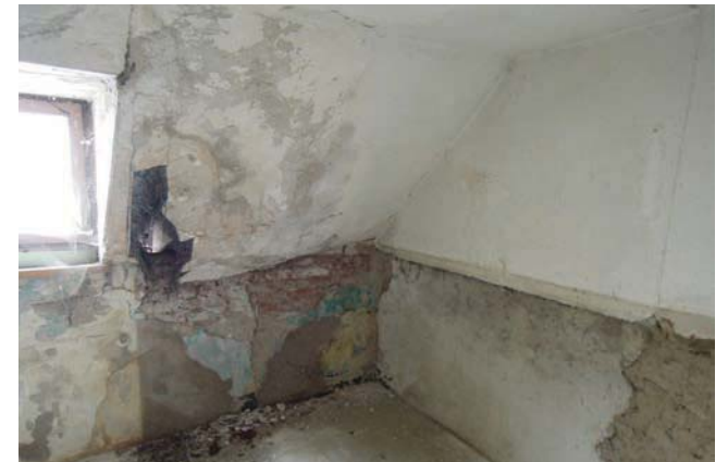
Fotos IST - Zustand
