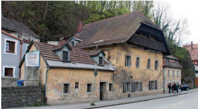
Das ehemalige Gasthaus "zur Fels'n"
