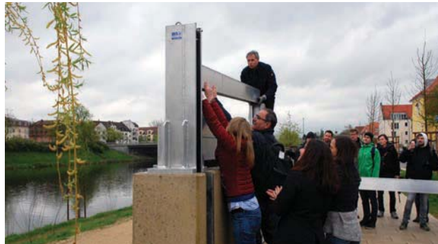
Aufbau des mobilen Hochwasserschutzes
