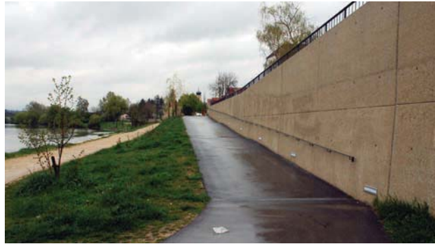
Hochwasserschutz am Donau-Seitenfluss "Regen"
