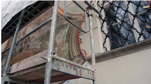
Stuckateurarbeiten an der Fassade des Lukas-Kern-Kinderheims
