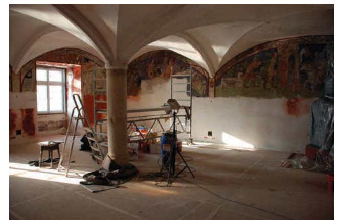
Restaurierungsarbeiten in der Veste Niederhaus
