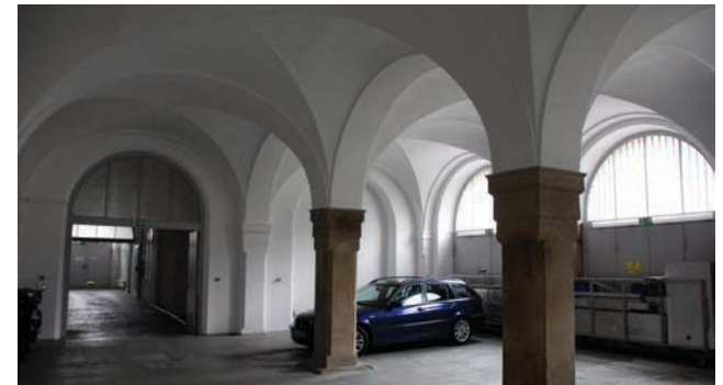
Im Erdgeschoss des ehemaligen Zollamts
