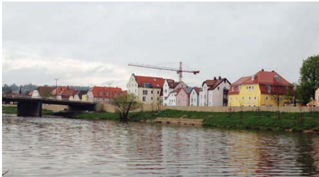
Hochwasserschutz am Regen
