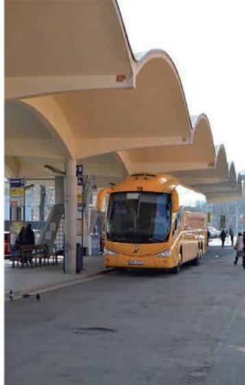
Betonschalenkonstruktion des Busbahnhofs mit Anschlussstelle für weiteren Bauabschnitt
