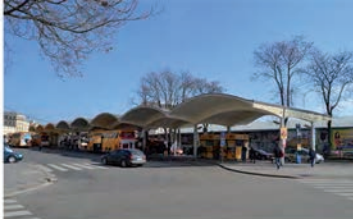
Betonschalenkonstruktion des Busbahnhofs mit Anschlussstelle für weiteren Bauabschnitt
